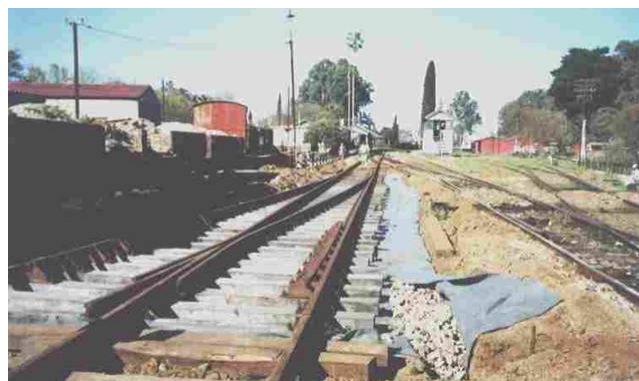
Instalação dos trilhos e execução da trincheira.
