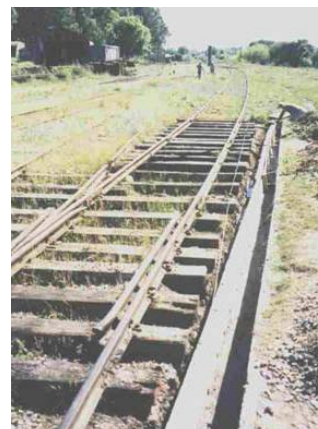
Aspecto do local antes do início dos trabalhos.
