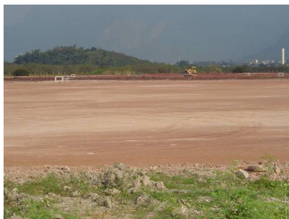
Vista geral da área pronta para receber tráfego de equipamento pesado e início do empreendimento.
