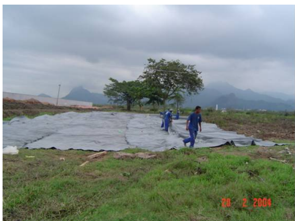
Lançamento da Manta Geotêxtil Bidim RT-31
