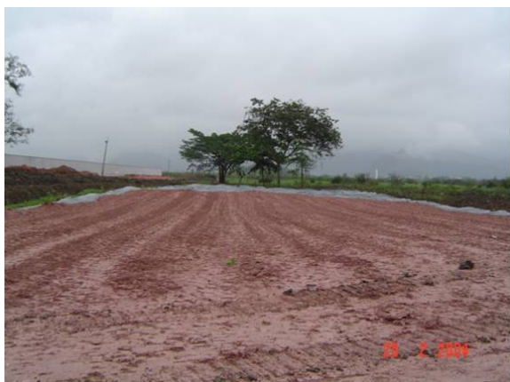
Execução do aterro
