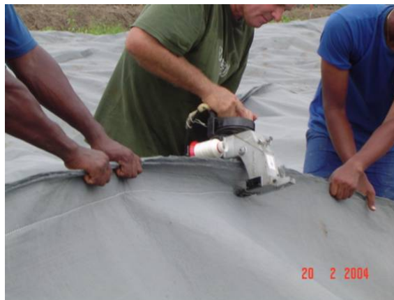
Costura da Manta Geotêxtil Bidim RT-31
