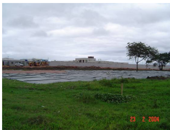
Lançamento da Manta Geotêxtil Bidim RT-31 e execução do aterro
