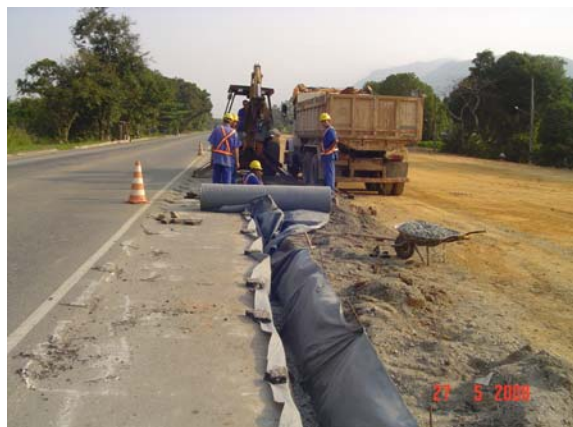
Instalação da Manta Geotêxtil Bidim RT-16 na trincheira drenante (dreno longitudinal).
