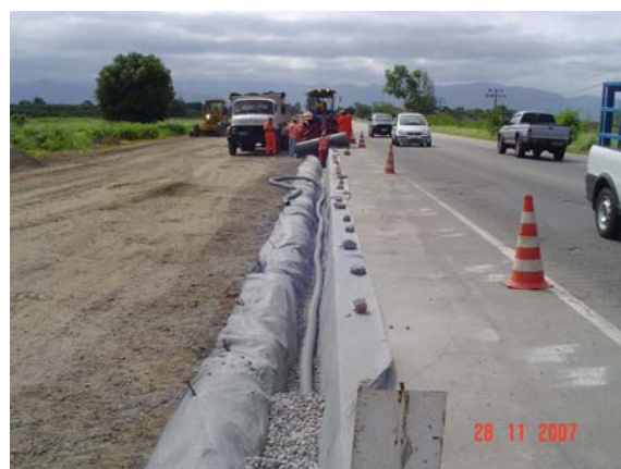
Instalação da Manta Geotêxtil Bidim RT-16, do tubo flexível de drenagem e início do preenchimento da trincheira com o material granular (Brita 2).
