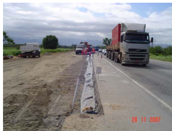
Envolvimento da trincheira drenante (dreno longitudinal) com a Manta Geotêxtil Bidim RT-16.
