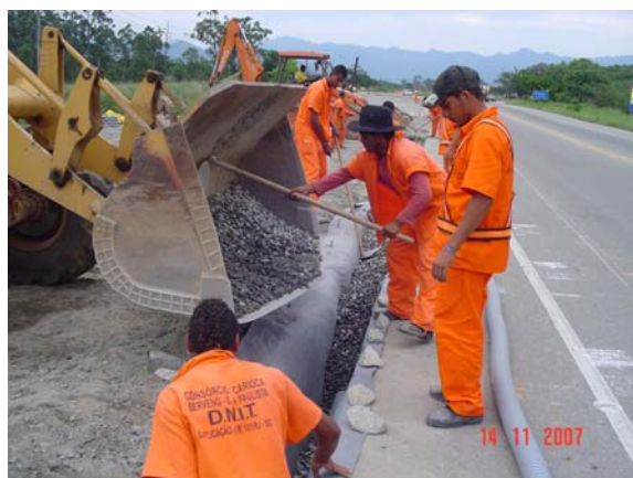
Preenchimento da trincheira drenante (dreno longitudinal) com material granular (Brita 2).
