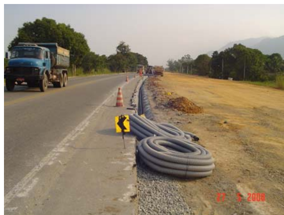
Instalação da Manta Geotêxtil Bidim RT-16 e do tubo flexível de drenagem (DN 110mm).
