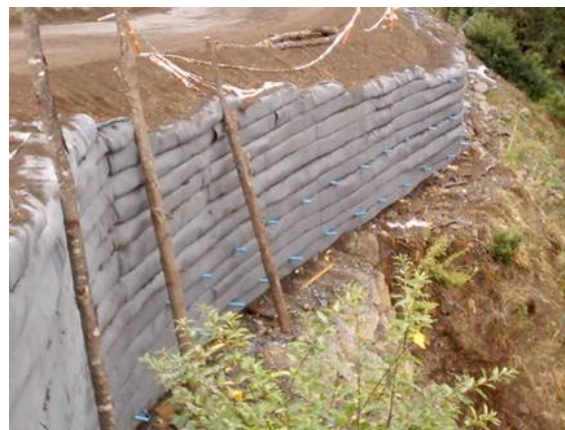
Vista geral de um dos muros concluídos. Notar os barbacãs para drenagem.
