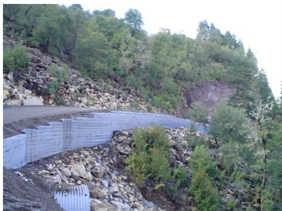
Vista geral de um dos muros concluídos.
