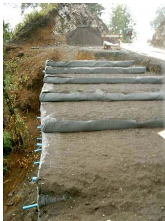
Execução do topo do muro em rampa, com degraus laterais. Vista da crista do maciço já concluído. Notar os detalhes dos barbacãs na face do muro.
