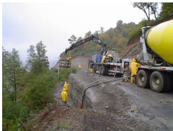
Execução da proteção da face com concreto projetado sobre tela metálica (espessura 5cm).
