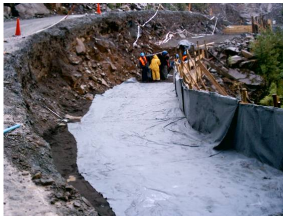
Instalação de uma das camadas da Manta Geotêxil Bidim RT-16, com a sobra para execução da dobra na face.
