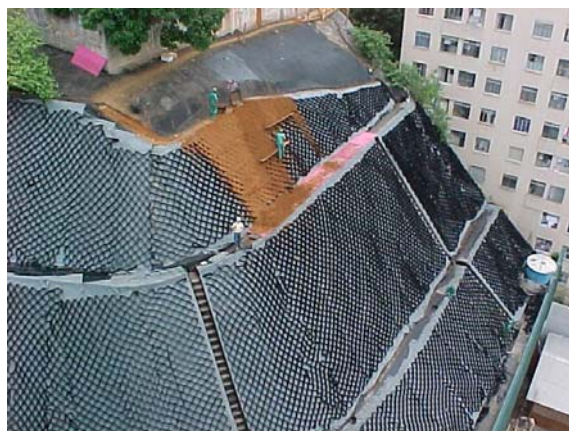
Vista geral do talude
