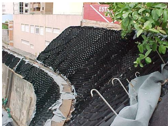
Instalação do Geoweb GW40V6 com grampos galvanizados.
