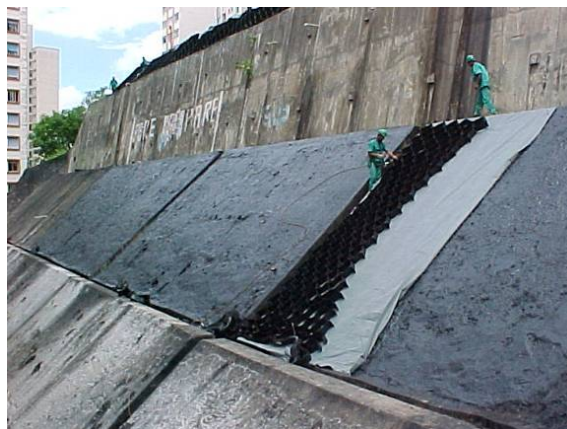
Instalação da Manta Geotêxtil Bidim RT-16 e Geoweb GW40V6
