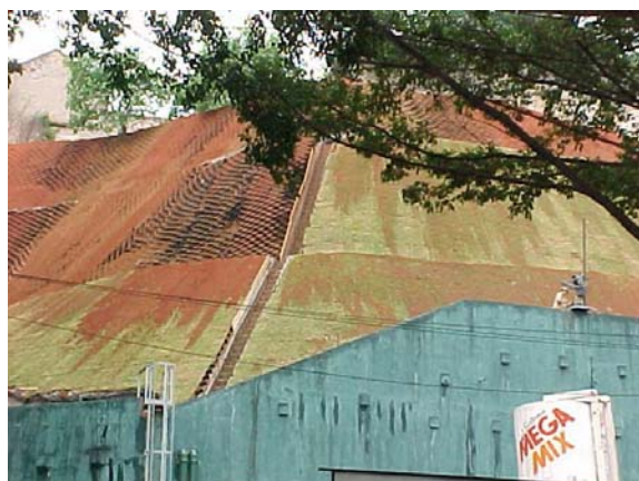
Preenchimento com solo. Vista da cortina atirantada.
