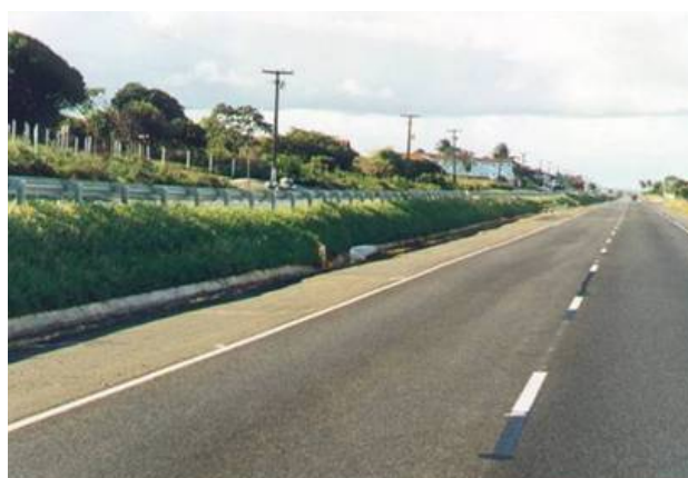
Vistas gerais do trecho após a pega da vegetação. Notar a cobertura vegetal completa do talude, evitando processos erosivos e proporcionando excelente aspecto visual.
