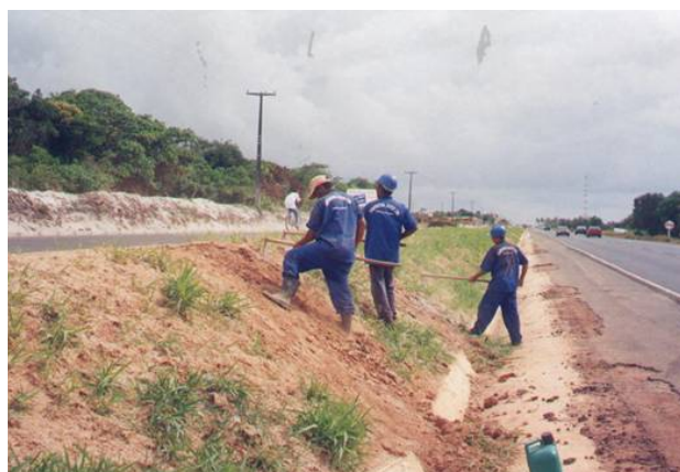
Preparação da superfície para aplicação do Geoweb GW40V3.
