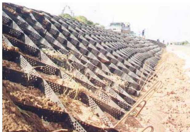
Geoweb GW40V3 instalado e pronto para ser revestido. Notar os ganchos de fixação na base do talude.
