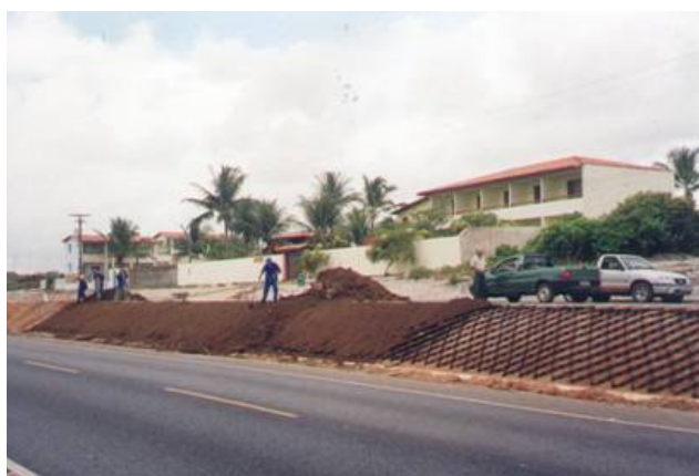
Preenchimento das células a partir do topo do talude.
