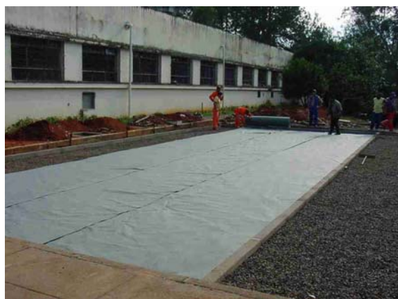
Pavimento já executado e lançamento da Manta Geotêxtil Bidim RT-16 no pavimento esquerdo.
