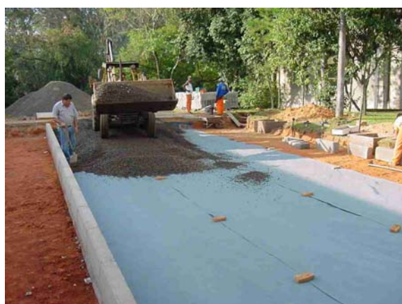
Lançamento de camada granular sobre a Manta Geotêxtil Bidim RT-16. Notar a sobreposição entre mantas.
