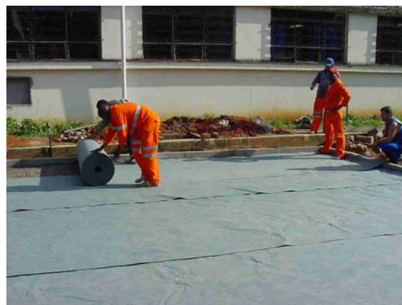
Instalação da Manta Geotêxtil Bidim RT-16
