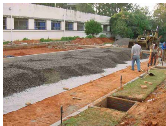
Lançamento de camada granular.
