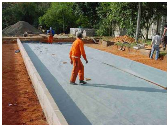
Instalação da Manta Geotêxtil Bidim RT-16
