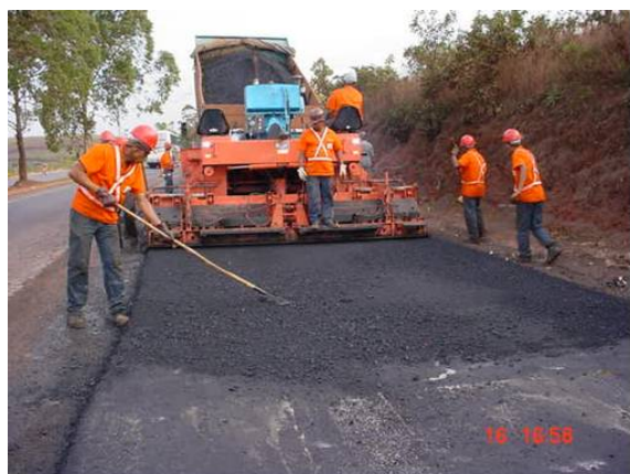
Vista do salgamento sobre a Manta Geotêxtil Bidim RT-08.
