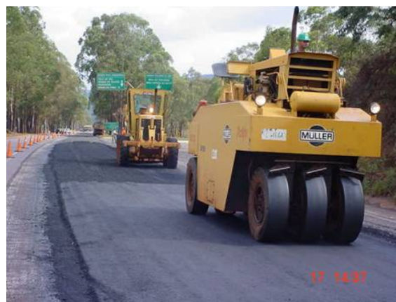
Vista da compactação do CBUQ.
