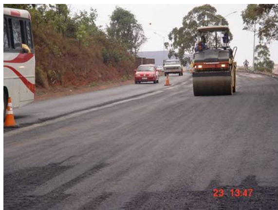
Vista da compactação feita com o rolo liso.
