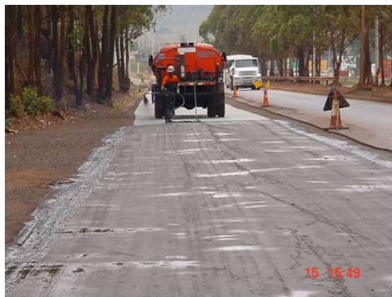
Vista da pintura de ligação sobre a Manta Geotêxtil Bidim RT-08.
