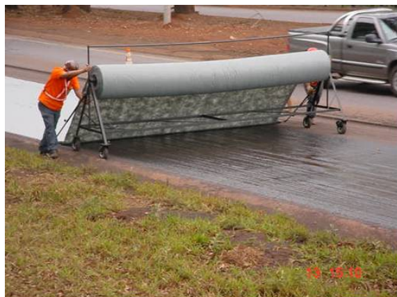
Vista do equipamento de instalação da Manta Geotêxtil Bidim RT-08.
