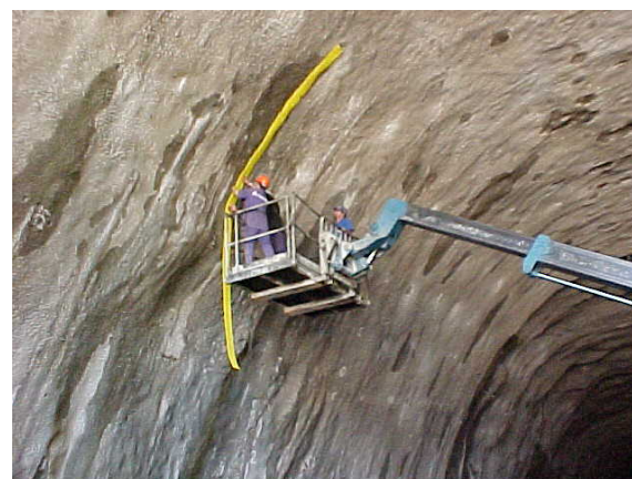
Instalação do Multidren Bidim em fitas com rebite (pneumático)
