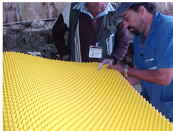
Corte do Multidren Bidim com faca no canteiro
