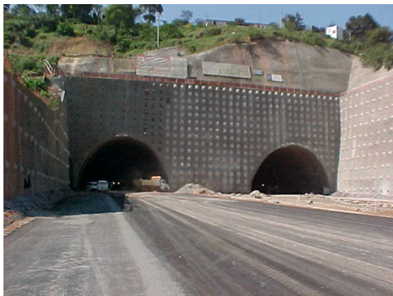
Emboque dos túneis
