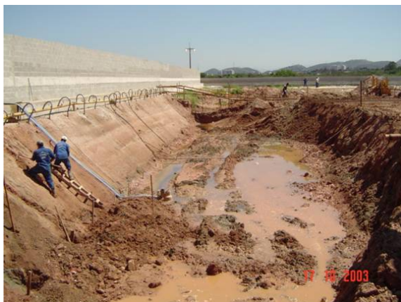
Escavação e rebaixamento do NA com ponteiros (crista do talude) e bomba submersa (fundo da escavação).
