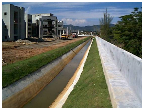
Canal menor concluído.
