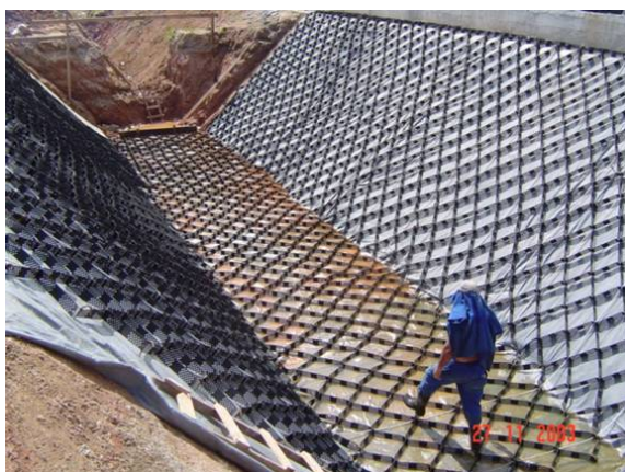
Canal menor em execução.
