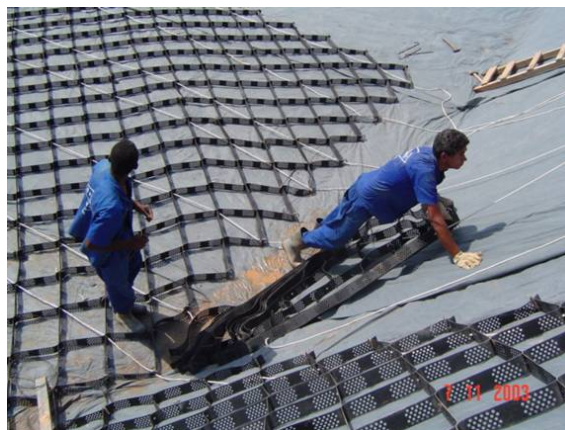
Detalhe da instalação do Geoweb GW40V3 com tirantes.
