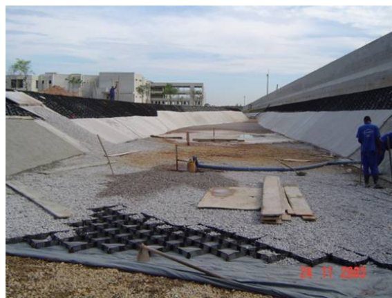
Instalação da Manta Geotêxtil Bidim RT-09 e do Geoweb GW40V3. Fundo do canal maior revestido com brita para evitar problemas de subpressão devido à oscilação do NA do terreno. Notar a bomba submersa para rebaixamento temporário do NA.
