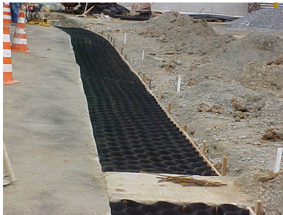
Aplicação da Geoweb.
