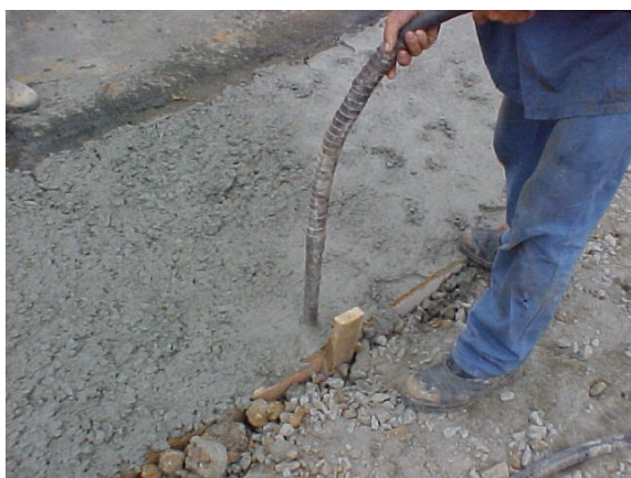
Vibração do concreto.
