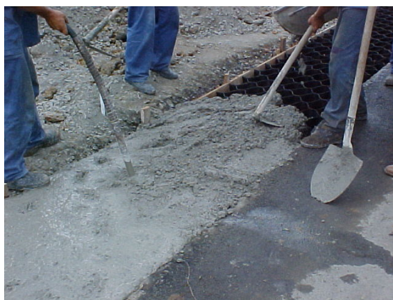
Vibração do concreto e acabamento.
