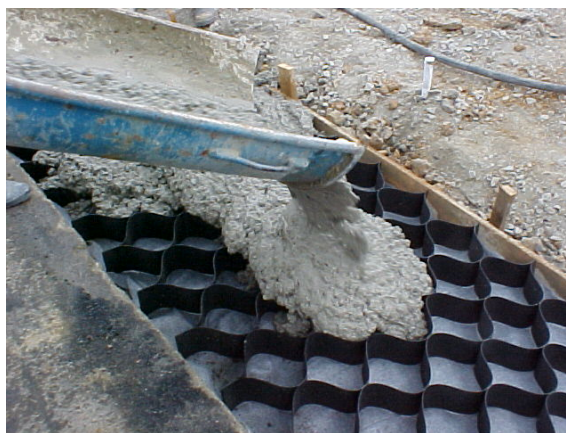
Detalhe da concretagem.
