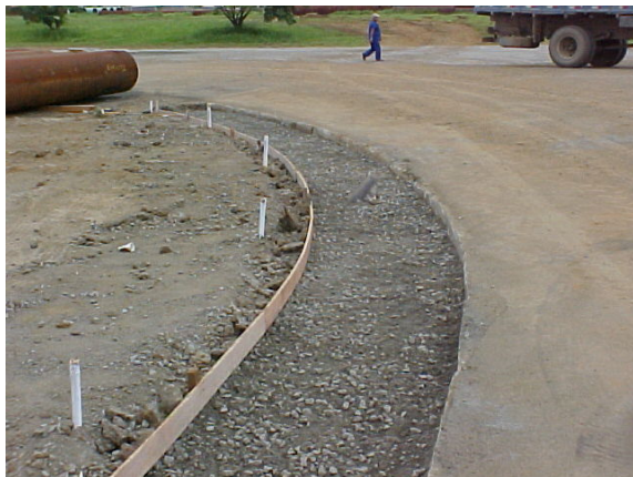
Preparação do trecho.
