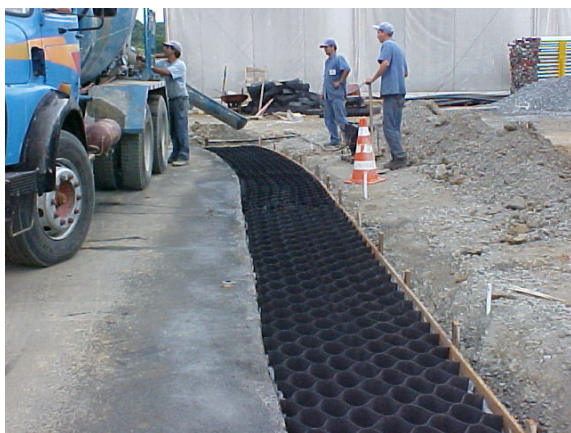
Preenchimento da GEOWEB com concreto.
