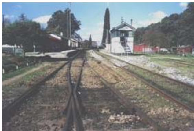
Aspecto do local antes do início dos trabalhos
