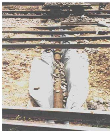
Execução do dreno transversal com Manta Geotêxtil Bidim RT-21.
