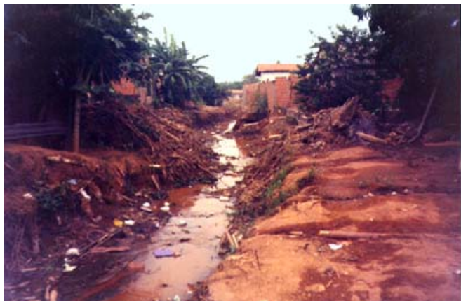
Aspecto do canal antes das obras.
