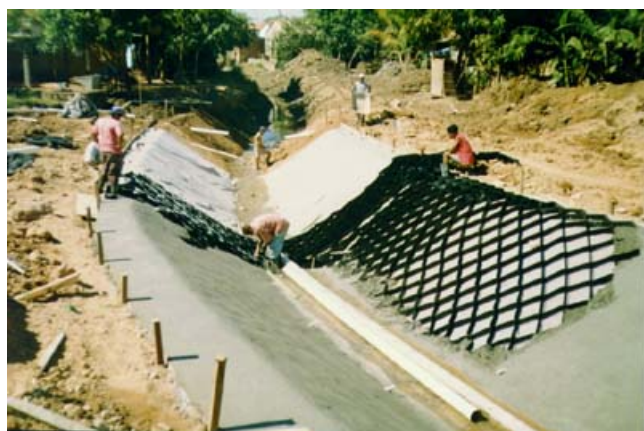
Vista geral de todas as etapas de execução do canal.
