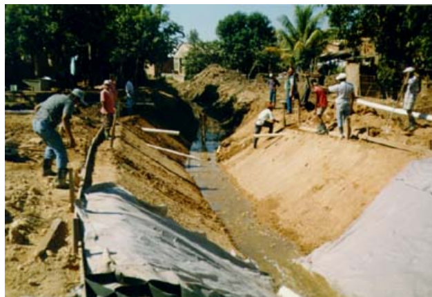
Preparo e colocação da Manta Geotêxtil Bidim RT-08.
