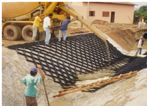
Lançamento do concreto sobre o Geoweb.
