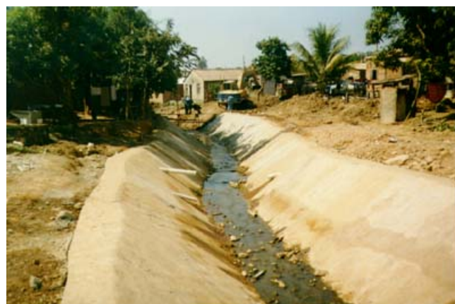
Aspecto final do canal concluído.
