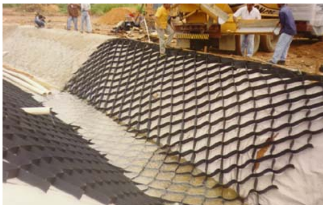
Geoweb instalado no canal.
