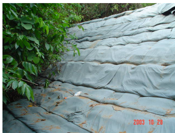
Vista da face envolvida com Manta Geotêxtil Bidim RT-26
