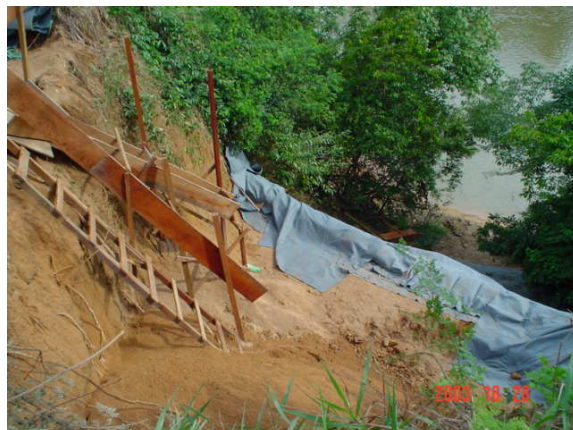
Execução do solo envolvido e lançamento da areia
