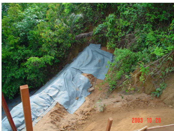
Execução do solo envolvido com Manta Geotêxtil Bidim RT-26
