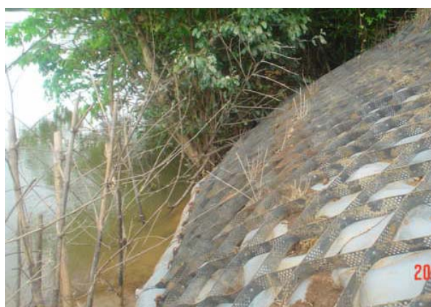
Instalação do Geoweb GW40V3
