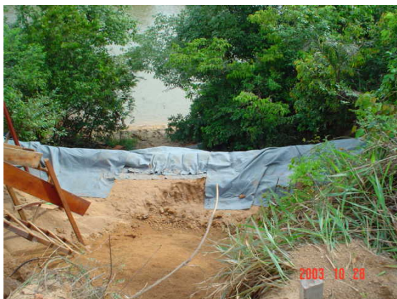
Vista geral da erosão e execução do solo envolvido com Manta Geotêxtil Bidim RT-26
