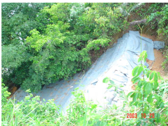
Vista geral do solo envolvido com Manta Geotêxtil Bidim RT-26
