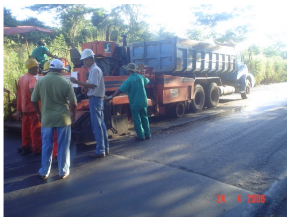
Aplicação do CBUQ sobre a Manta Geotêxtil Bidim RT-09.
