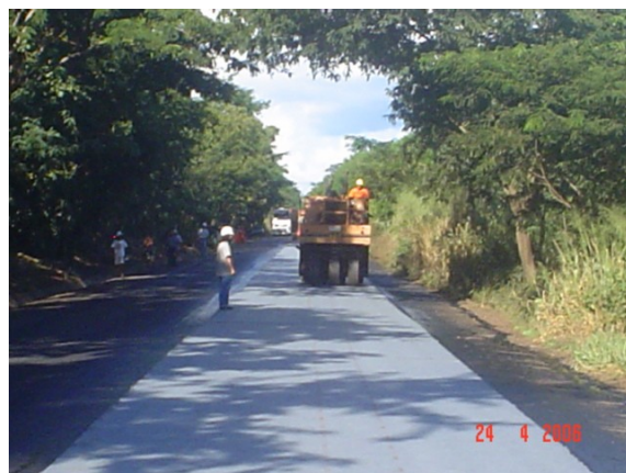
Compactação da Manta Geotêxtil Bidim RT-09 (penetração invertida).
