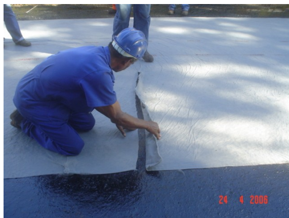
Corte e tratamento das dobras (não podem ocorrer).
