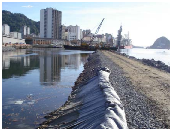
Manta Geotêxtil Bidim RT-21 no lado interno do Dique.
