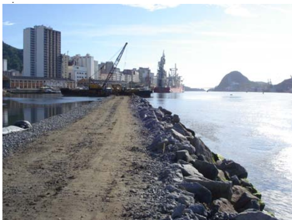
Vista do lado externo do Dique.
