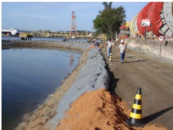
Início do enrocamento. Manta Geotêxtil Bidim RT-21 já instalado.
