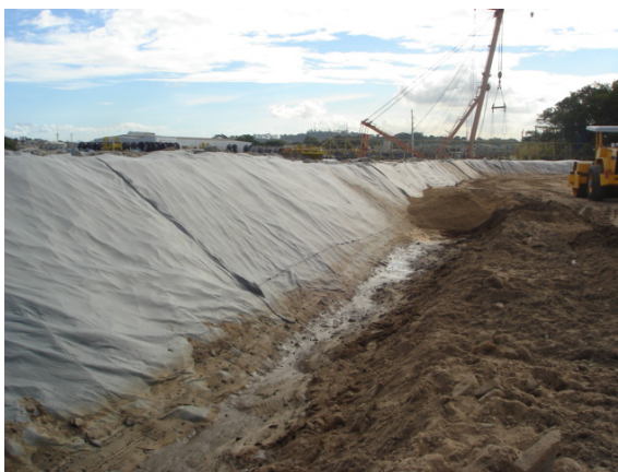
Vista da Manta Geotêxtil Bidim RT-21 sobre o dique e a areia do aterro hidráulico.
