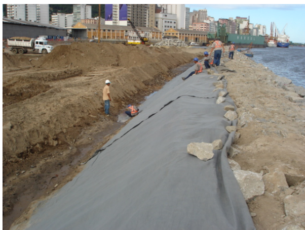
Vista da Manta Geotêxtil Bidim RT-21 sobre o talude do Dique.
